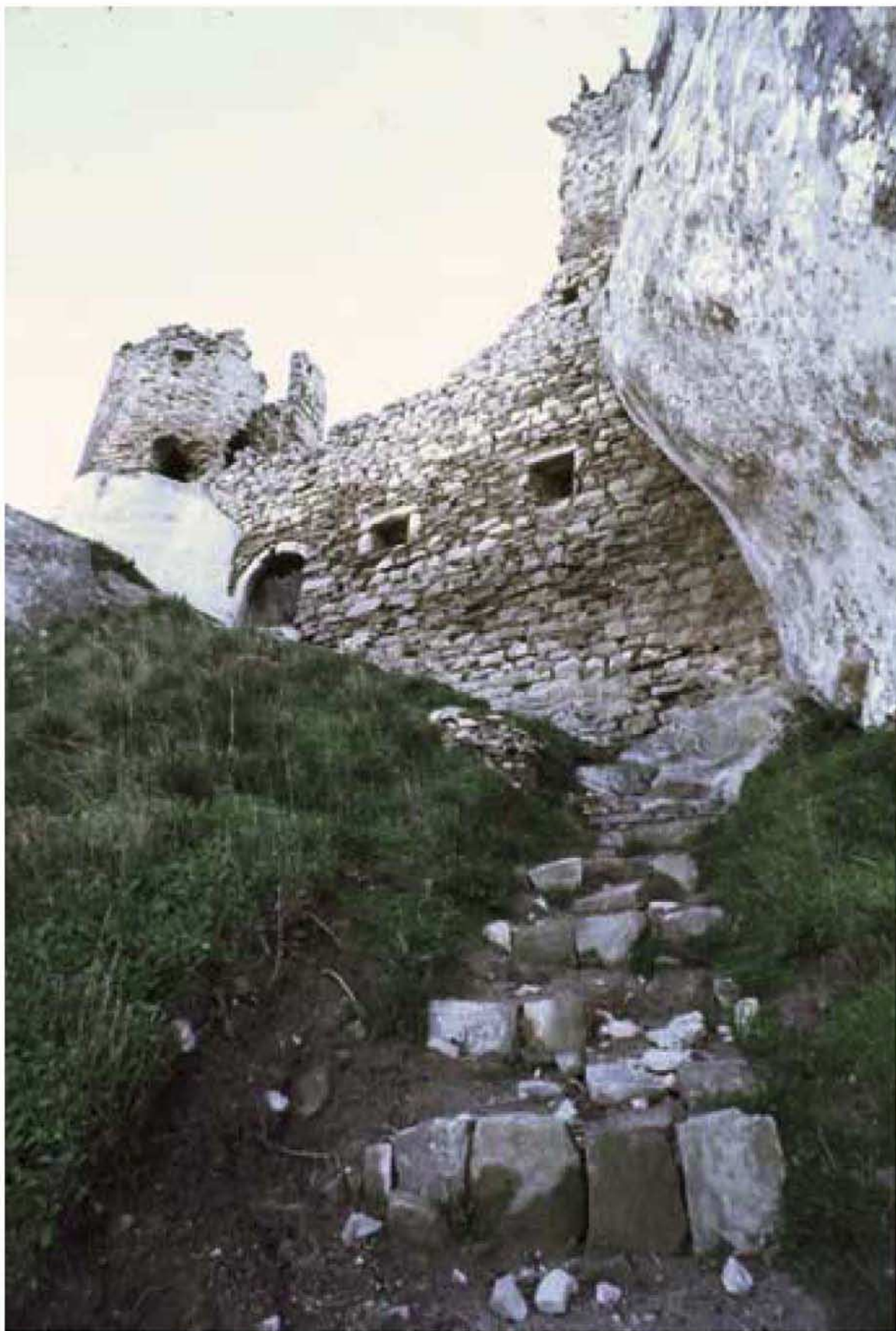
Pietrapertosa (Pz), il castello in parte ricavato nel paesaggio rupestre (Foto Ottavio Chiaradia)
